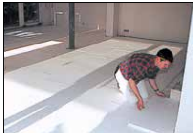
Plaatsing van de warmte- en contactgeluidsisolatie op voldoende draagvaste en vlakke ondergrond
