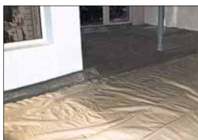
Inbouw van de scheidingslaag
