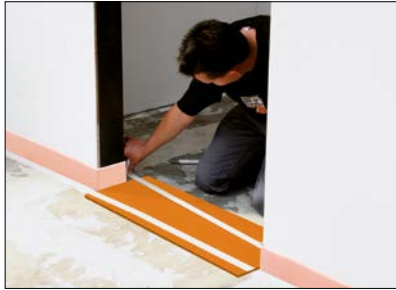
6 Türbereich – beigefügte Doppelklebebänder aufbringen.
