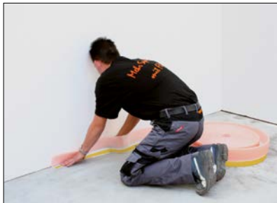
2 Einbau des Randstreifens BRS 808 KSF mit Klebestützfuß.
