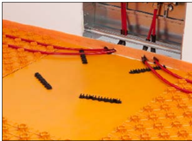
11 Verteilerbereich – Rohrklemmleisten BTZRKL 10/12 zur Rohrführung nach Bedarf aufkleben.
