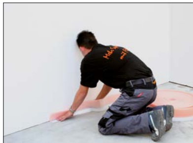
2 Einbau des Randstreifens BRS 808 KSF mit Klebestützfuß.
