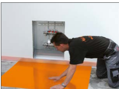
4 Verteilerbereich – Ausgleichsplatte Schlüter-BEKOTEC-EN FG (glatte Folienplatte) einpassen.
